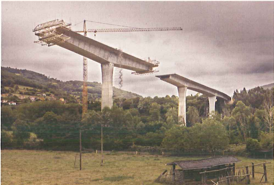
Viaducto sobre el Narcea en noviembre de 2016
