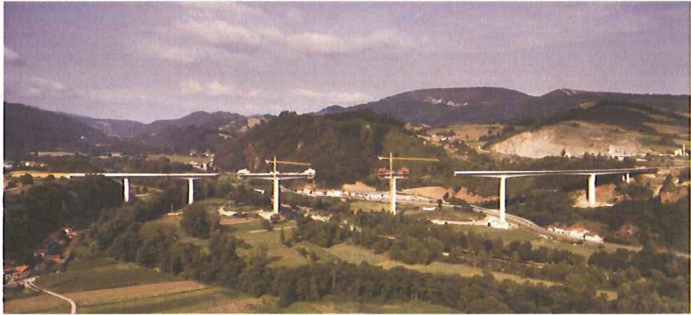
Viaducto sobre el Narcea en noviembre de 2016
