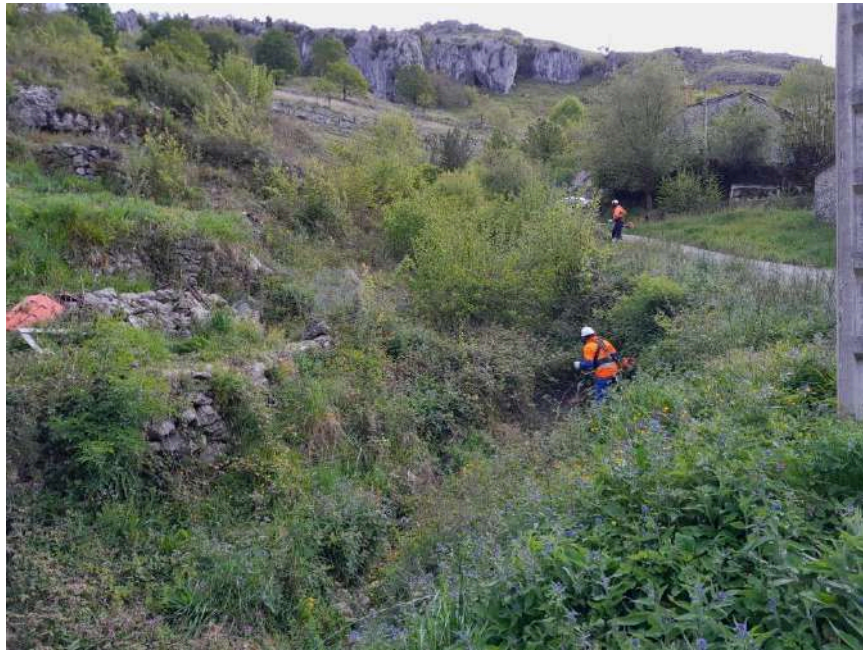
Trabajos de desbroce de la vegetación en el cauce del arroyo
