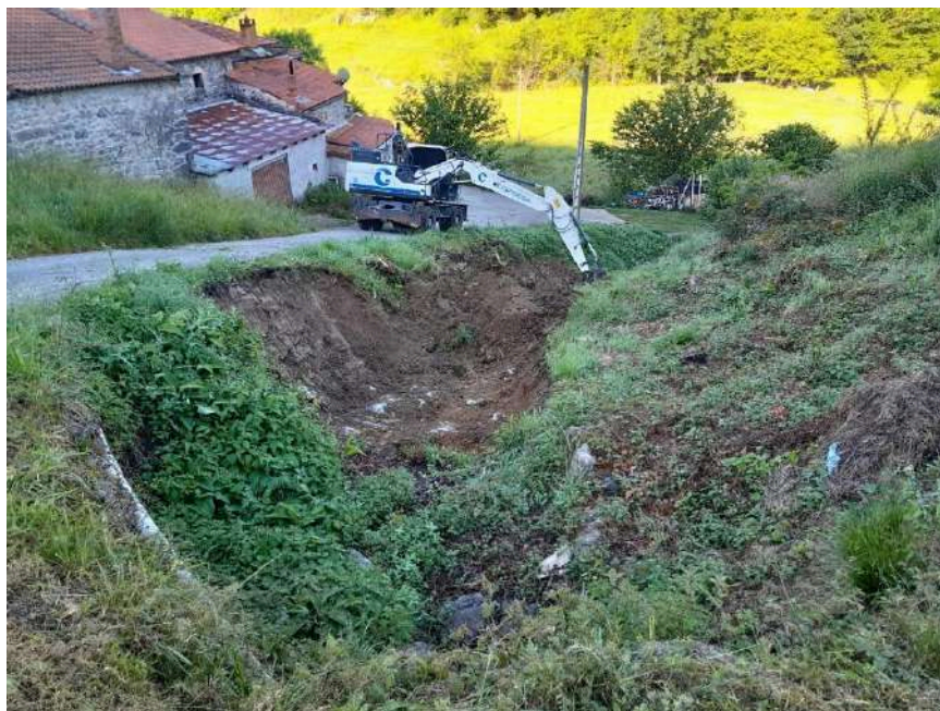
Trabajos de estabilización del talud de la margen izquierda
