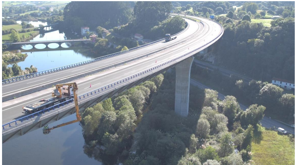
Inspecciones A-8. Viaducto de Tina Menor
