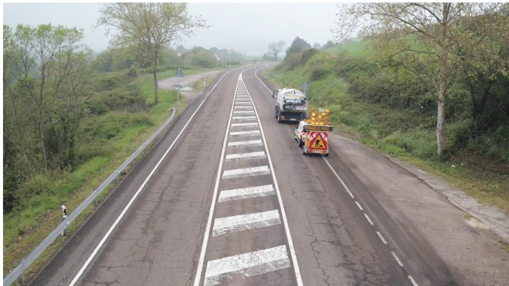
Limpieza con barredora en la N-634
