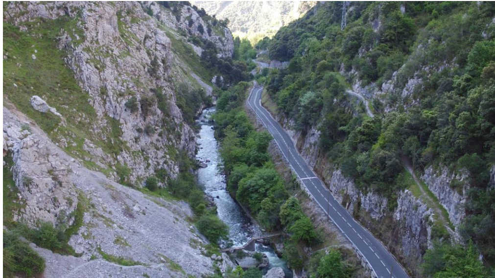
Tramo Desfiladero de la Hermida en la N-621
