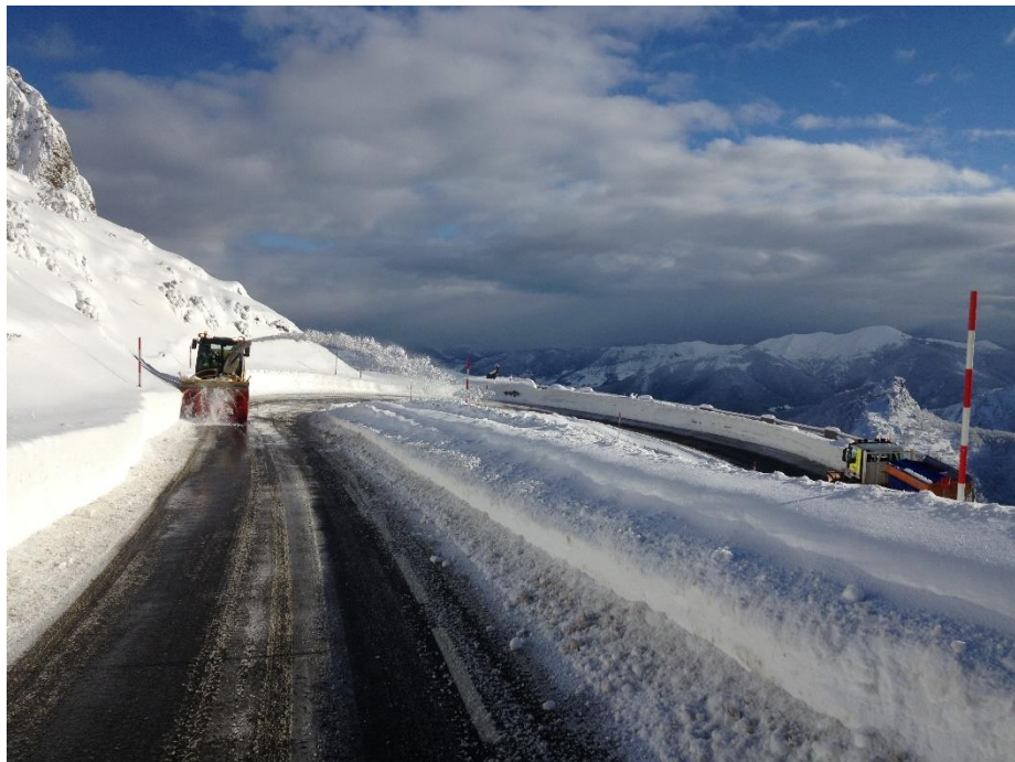
Retirada de nieve en la N-621
