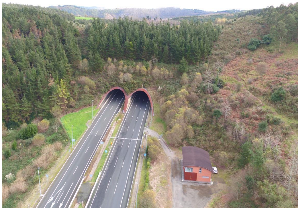
Túnel de Caviedes A-8 (pk 255+250)
