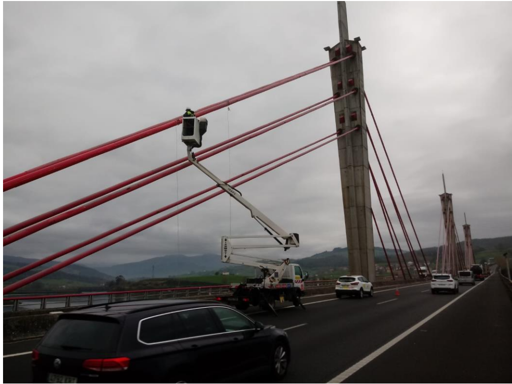
VIADUCTO DE COLINDRES A-8 P.K. 174+850
