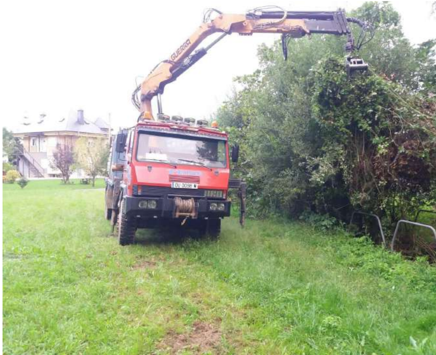
Extracción de restos vegetales del interior del cauce
