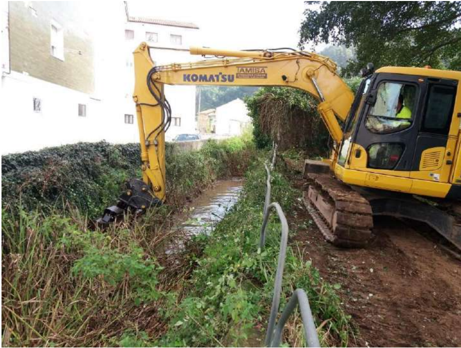
Dragado del tramo encauzado del río
