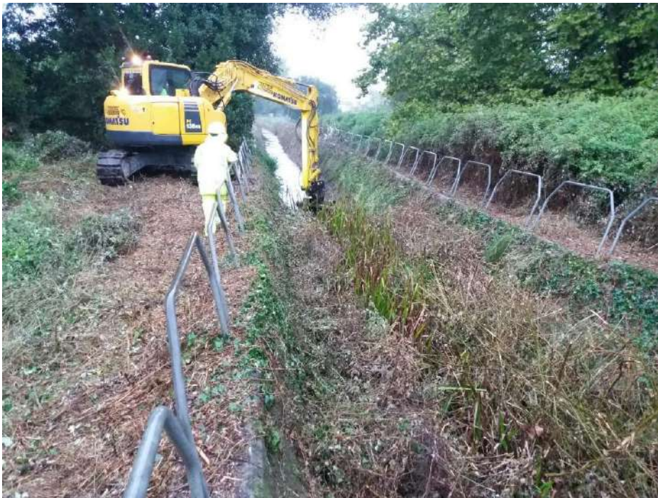
Dragado del tramo encauzado del río
