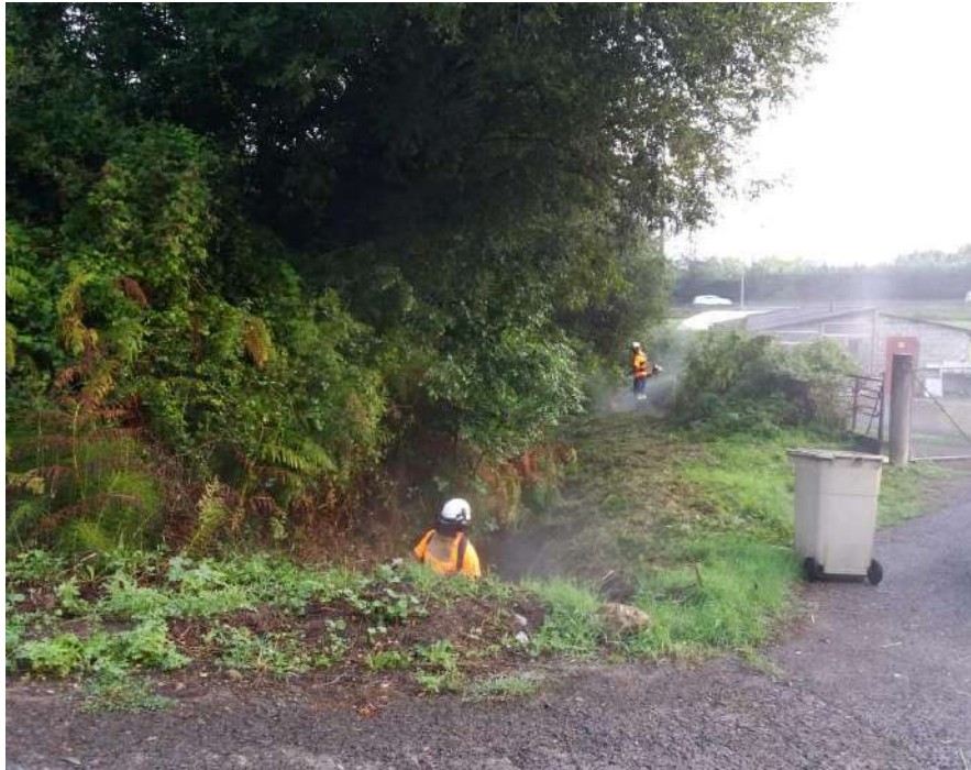
Trabajos sobre la vegetación presente en el cauce
