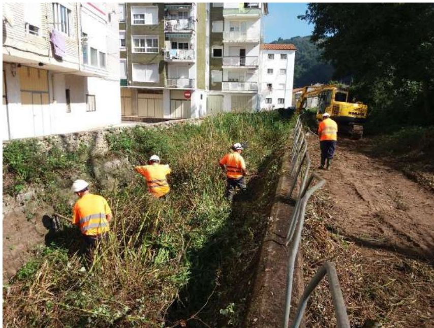
Trabajos sobre la vegetación presente en el cauce
