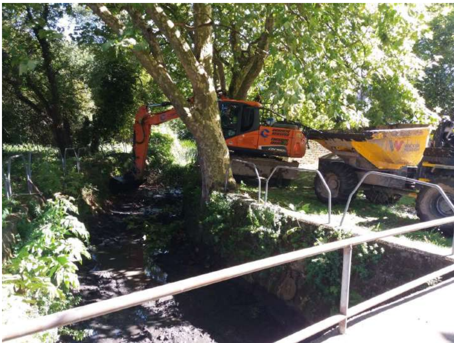
Dragado del tramo encauzado del río
