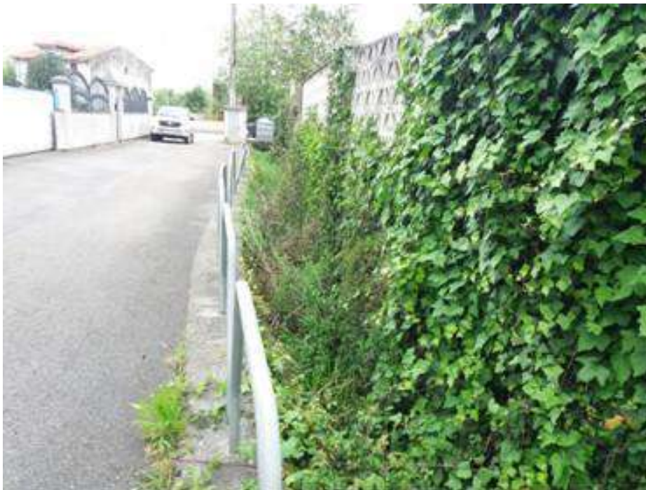
Situación previa del tramo de actuación en el arroyo la Maderuca
