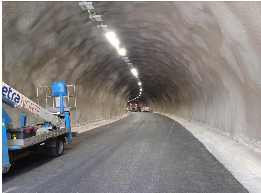
Ilustración 2. Instalación de alumbrado (157 luminarias LED)
