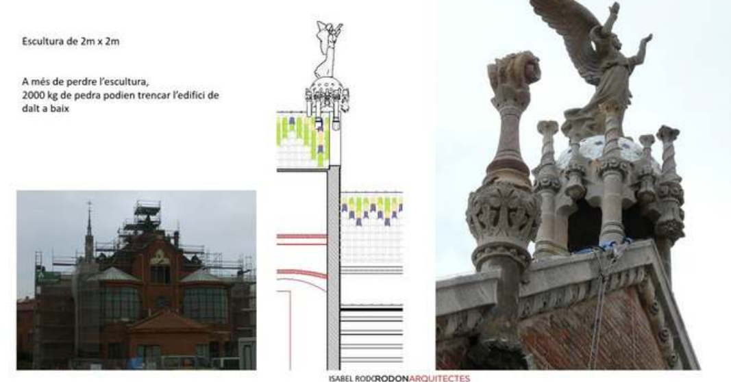
L’anell metàl·lic que suporta el cupulí estava a punt de trencar-se
